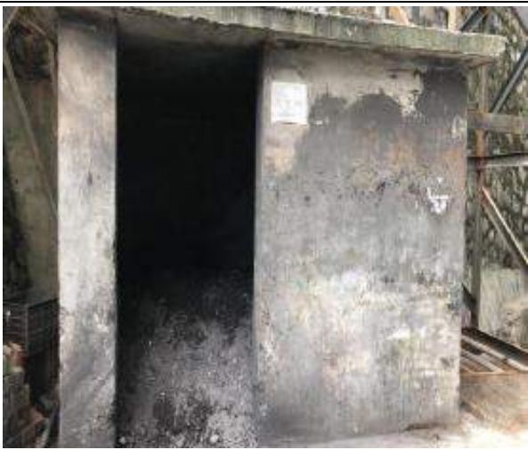
一般固废暂存间
