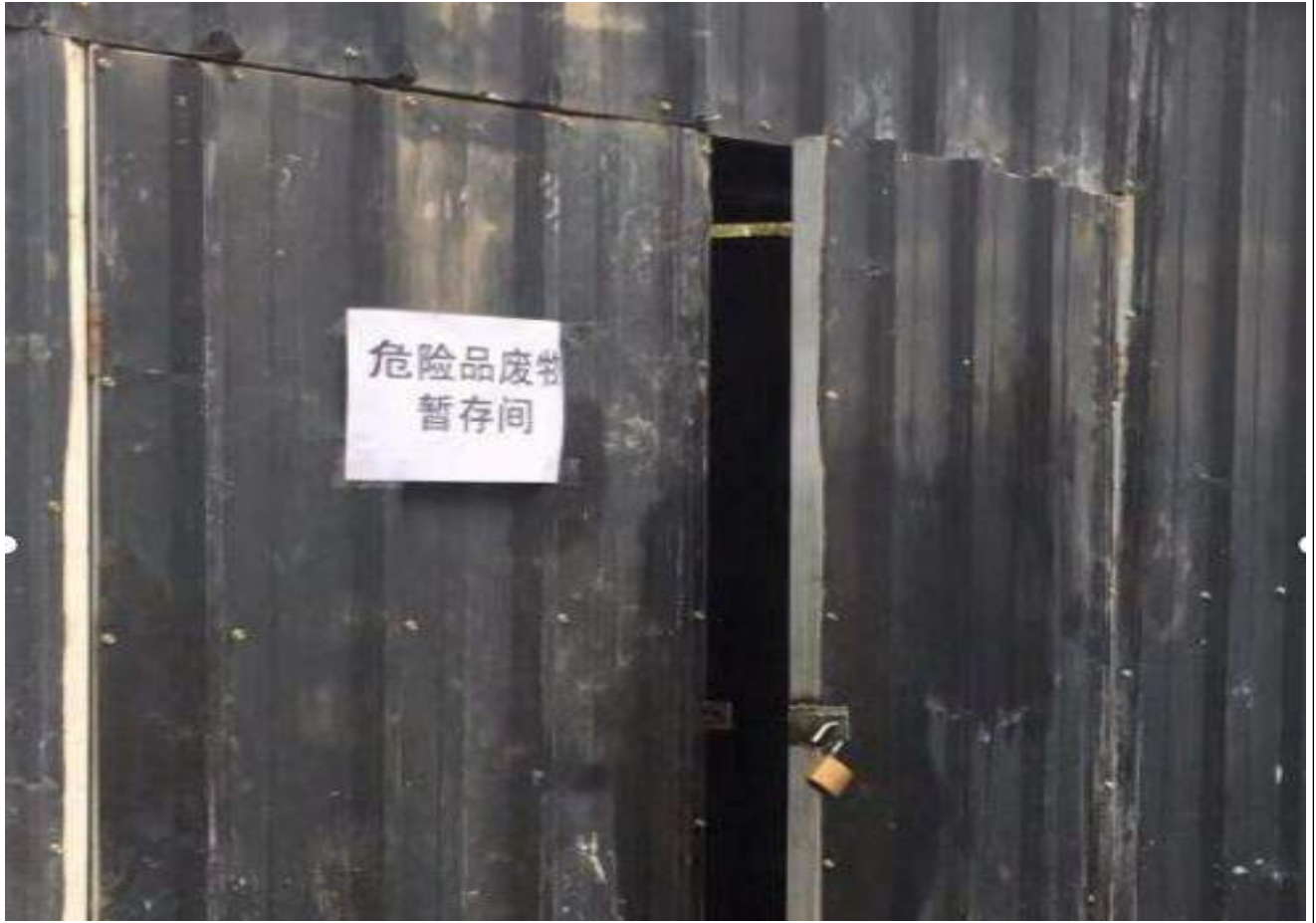
附图2、危废暂存间
