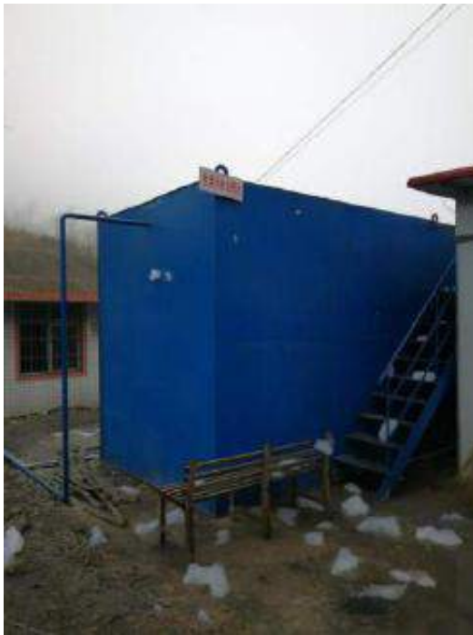
生活污水处理站
